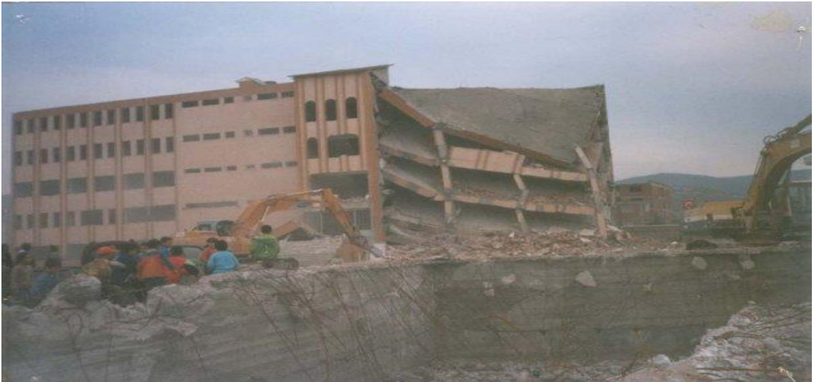
( 1999 Marmara depreminde yıkılan okulumuz )
