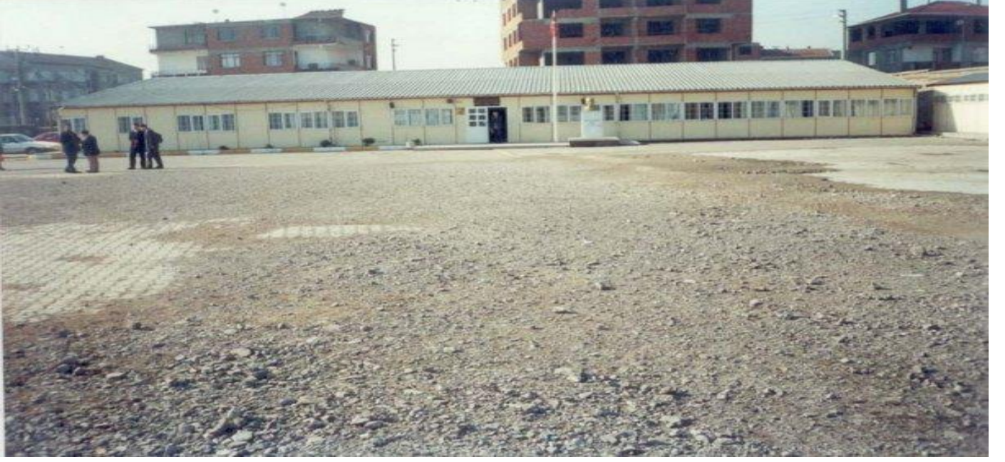
( Prefabrik binada eğitime devam ettik )
